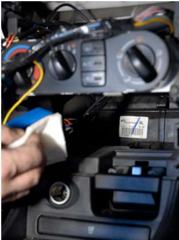
Обезжириваем блок управления...
