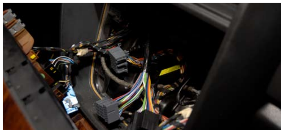
Укладываем кабель в нишу под корзиной аудиоустройств
